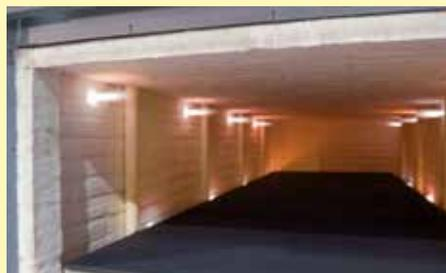
Vano interno del forno con otto bruciatori ad alta velocità
