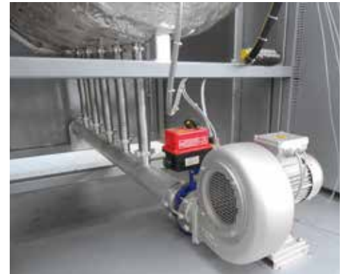
Gebläsekühlung Heißwand-Retortenofen NRA 400/03
